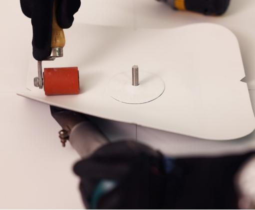
Para usar con membranas de TPO y PVC.\* El profesional de diseño del proyecto determinará la ubicación y la cantidad de montajes, además de la cantidad de sujetadores por montaje, para que resista a las presiones calculadas. Las siguientes instrucciones están destinadas para su uso por parte de un contratista de techo experimentado y profesional, utilizando el equipo, las técnicas y los protocolos de seguridad adecuados.
