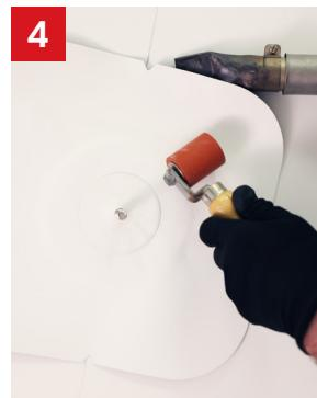
3 Suelde con aire caliente el borde perimetral de la membrana de la cubierta con un rodillo de 2 pulgadas para lograr una soldadura mínima de 2 pulgadas alrededor del perímetro. Explore la unión para asegurarse de que la membrana esté soldada correctamente.
