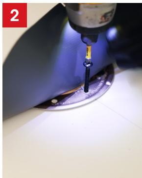
2 Instale el Soporte para equipo de techo 240 de GAF utilizando el tipo y la cantidad correctos de sujetadores especificados por su profesional de diseño.
