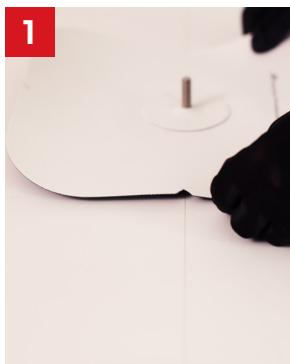
1 Alinee el Soporte para equipo de techo 240 de GAF según el diseño. La mayoría de los diseños se transfieren a la superficie del techo con marcas de tiza. Las muescas guía se pueden utilizar para alinearse con el diseño de la matriz solar para garantizar que la instalación sea más fácil y precisa. Evite usar tiza permanente.
