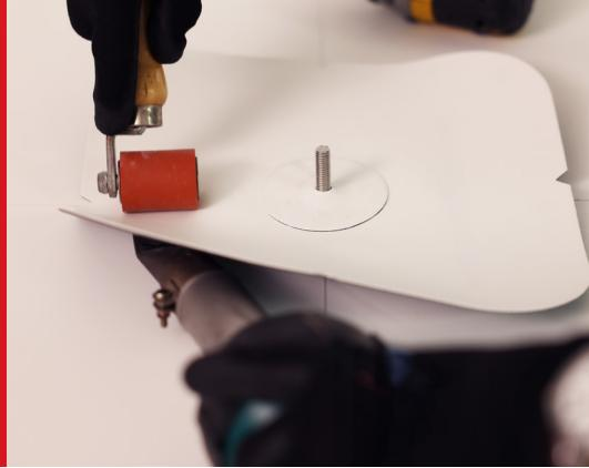
À utiliser avec les membranes en TPO et PVC.\* L'emplacement et le nombre de supports, en plus du nombre de fixations par support, seront déterminés par le professionnel de la conception du projet pour résister aux pressions calculées. Les instructions suivantes sont destinées à être utilisées par un entrepreneur en couverture professionnel et expérimenté à l'aide de l'équipement, des techniques et des protocoles de sécurité appropriés.
