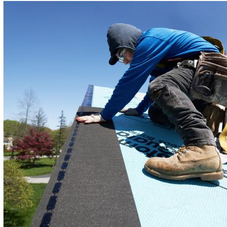
Se instala en los aleros y bordes de inclinación para ayudar a evitar la voladura de tejas.
