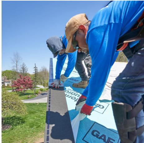
El autoadhesivo elimina la necesidad de cortar y clavar hiladas iniciales.
