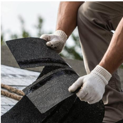
Se déchire en deux facilement le long de la perforation pour une installation facile
