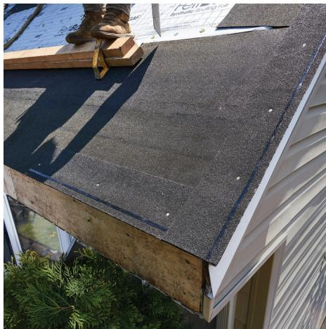
S'installe aux avant-toits et aux inclinaisons pour prévenir l'arrachement des bardeaux par le vent
