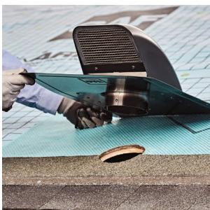
Corte de abertura circular de 5.5" (140 mm) de diámetro en la cubierta del techo con plantilla incluida en el empaque.
