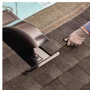
Las tejas se extienden sobre la parte superior y los lados del tapajuntas base y se cortan alrededor de la campana para lograr un aspecto limpio y acabado.
